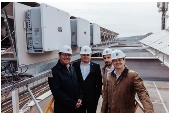
Bild: 03 CCA PV Anlage 2024.jpg
